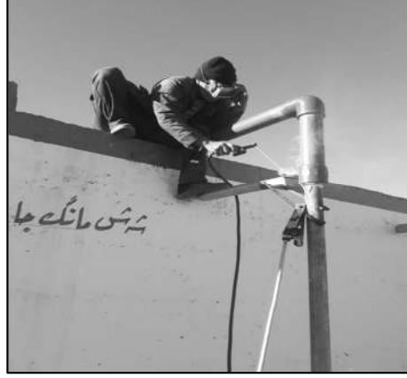
خزان تجميع المياه داخل الناحية، إلتقطت بتاريخ (٢٠٢١/١٢/١٢)
